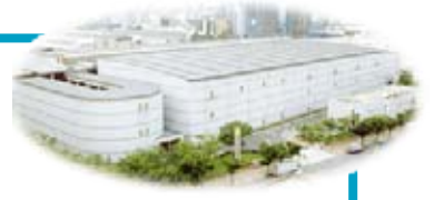
深川政府倉庫
